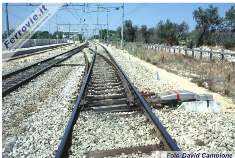
3. Una coppia di deviatori, anche chiamata "comunicazione", la cui manovra avviene attraverso la pulsantiera per la costruzione degli itinerari, posta sul Banco di Manovra del Dirigente Movimento (vedi foto successiva). (Foto David Campione, 12 agosto 1997)
