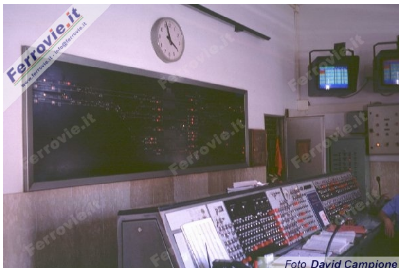
4. Banco ACEI della stazione di Roma Tuscolana. Sulla parete, in posizione frontale rispetto gli operatori, si trova il quadro luminoso, mentre sul banco è riconoscibile la pulsantiera per la costruzione dell'itinerario. (Foto David Campione, 22 giugno 1998)
