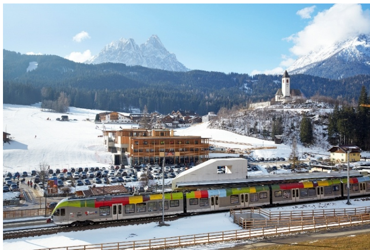
La nuova stazione ferroviaria di Versciaco-Monte Elmo (Foto USP Bolzano)
