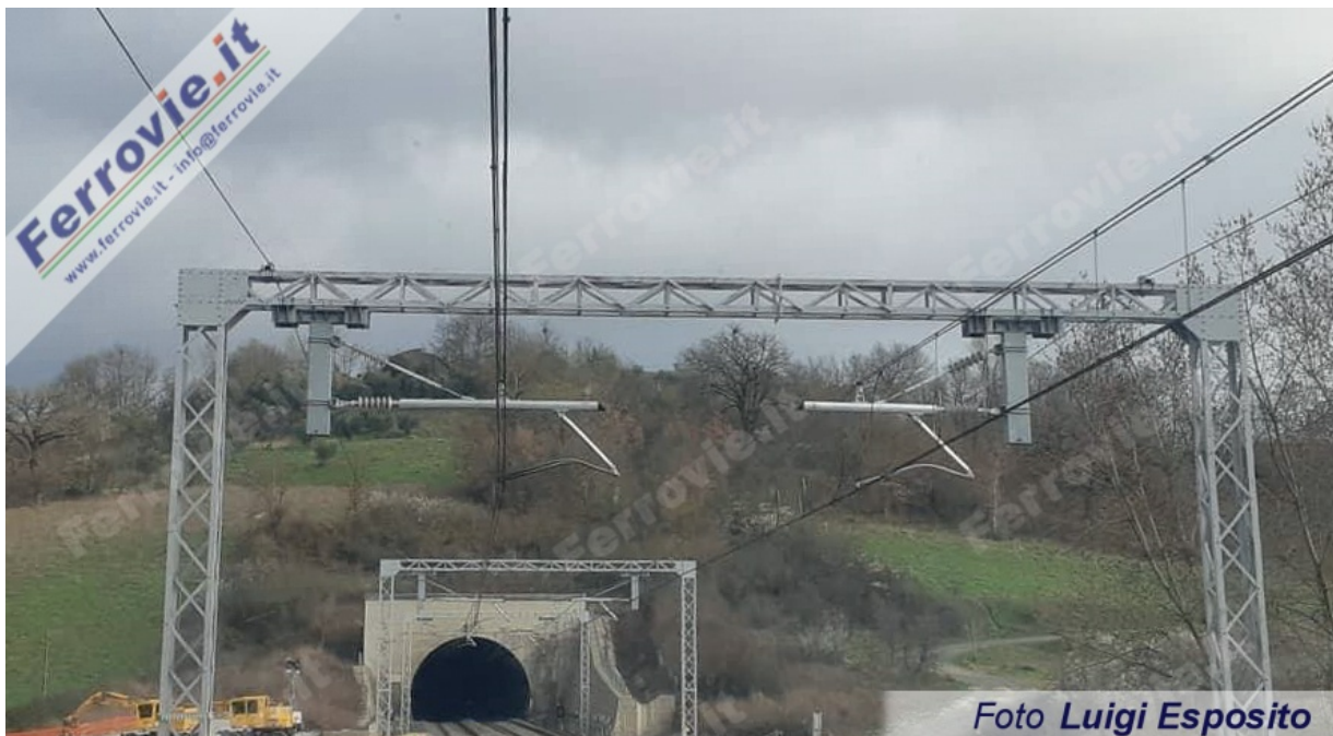
22 Un particolare delle nuove mensole. (Foto Luigi Esposito)
