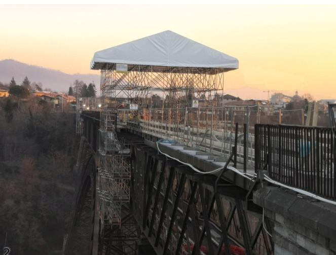
Nelle attività di cantiere sono stati impegnati complessivamente 40 fra ingegneri, tecnici e operai di RFI e delle ditte appaltatrici, per un totale di circa 75mila ore di lavoro complessive. Le lavorazioni sono state fatte senza soluzione di continuità nelle 24 ore, utilizzando un innovativo sistema di ponteggi sospesi che ha permesso di lavorare con agilità a 85 metri di altezza.
