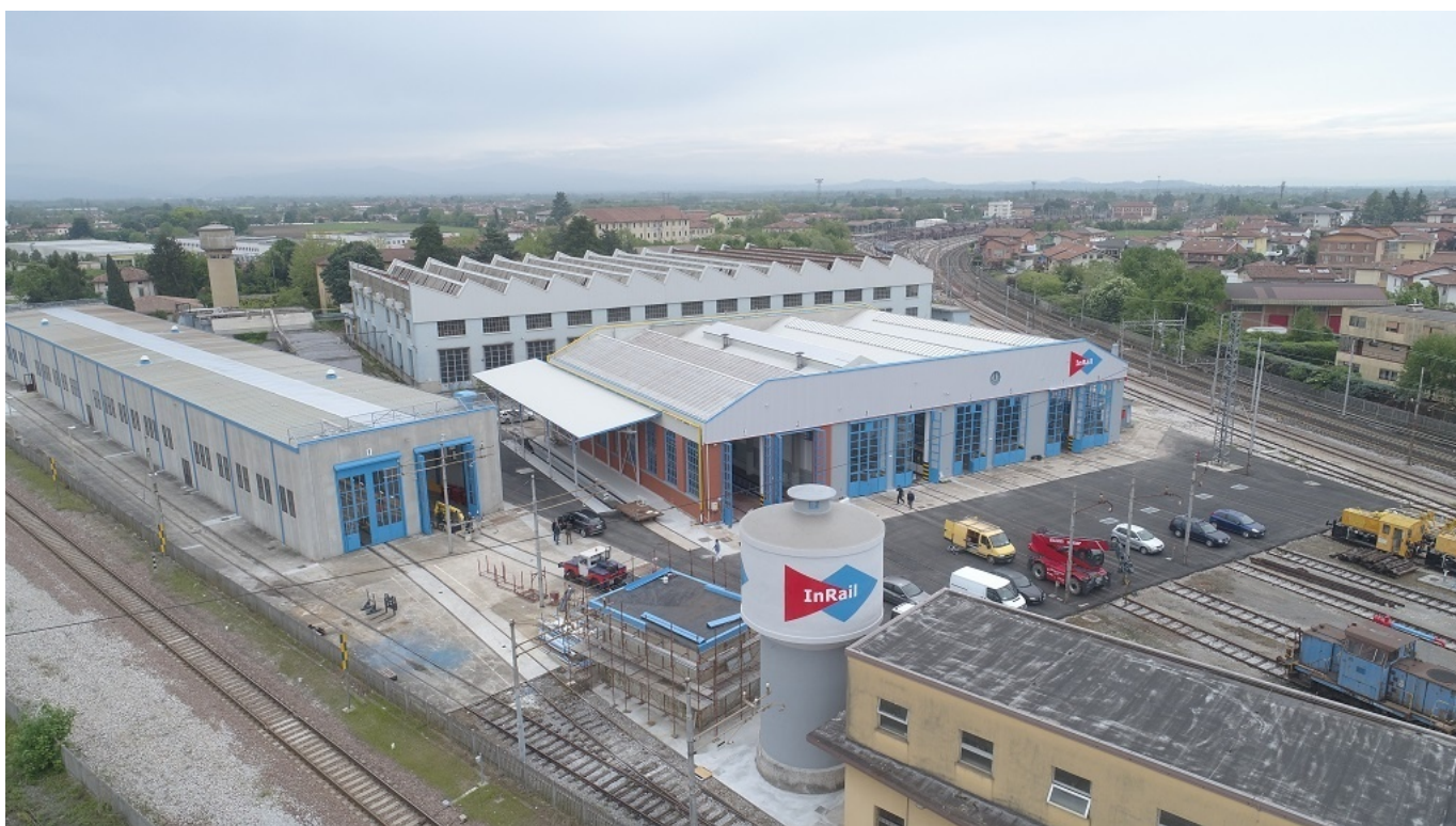
1.1 Panoramica della nuova Officina Manutenzione Rotabili di InRail a Udine. (Foto InRail)
