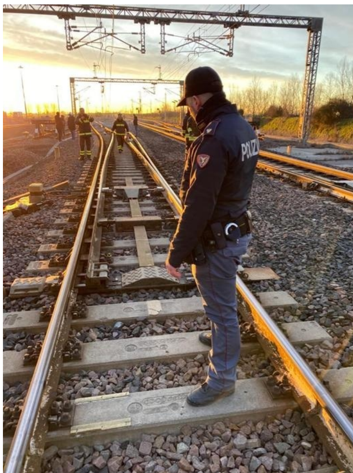
2. Il deviatoio percorso dal 9595 al momento dello svio, nella direzione della fotografia. Lo scambio è chiaramente rivolto verso il binario di precedenza. Foto ANSA, 06 febbraio 2020
