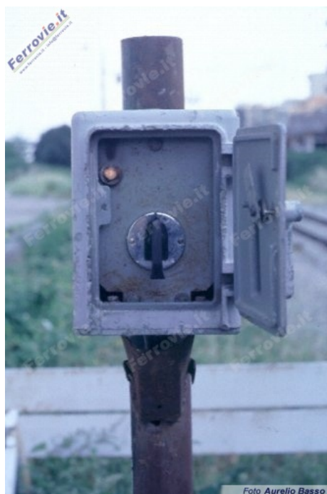
2, Dispositivo CL per la richiesta di apertura del segnale di partenza di Gragnano al DM di Castellammare, che funge da DCO. (Foto Aurelio Basso, 26 maggio 1999)
