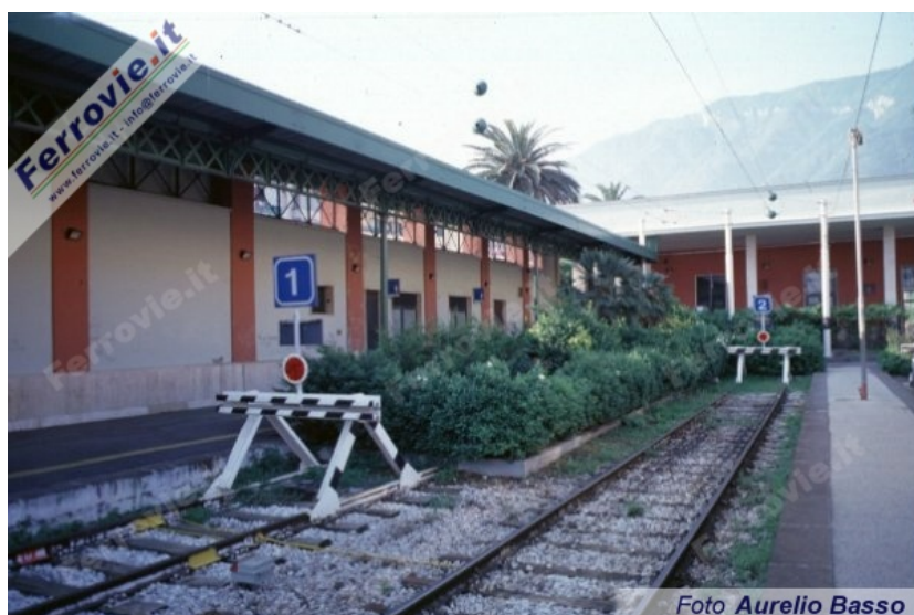
8. Il primo binario della stazione di Castellammare, con l'aiuola posta dinanzi al tronchino che ha preso il posto del terrapieno in sabbia a protezione del fabbricato viaggiatori visibile sullo sfondo. (Foto Aurelio Basso, 26 maggio 1999)
