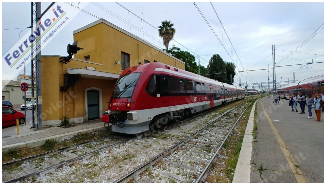
La stazione di Bari Sud Est (FSE), che sarà demolita per fare spazio alla variante Bari Centrale - Bari Torre a Mare di RFI.
