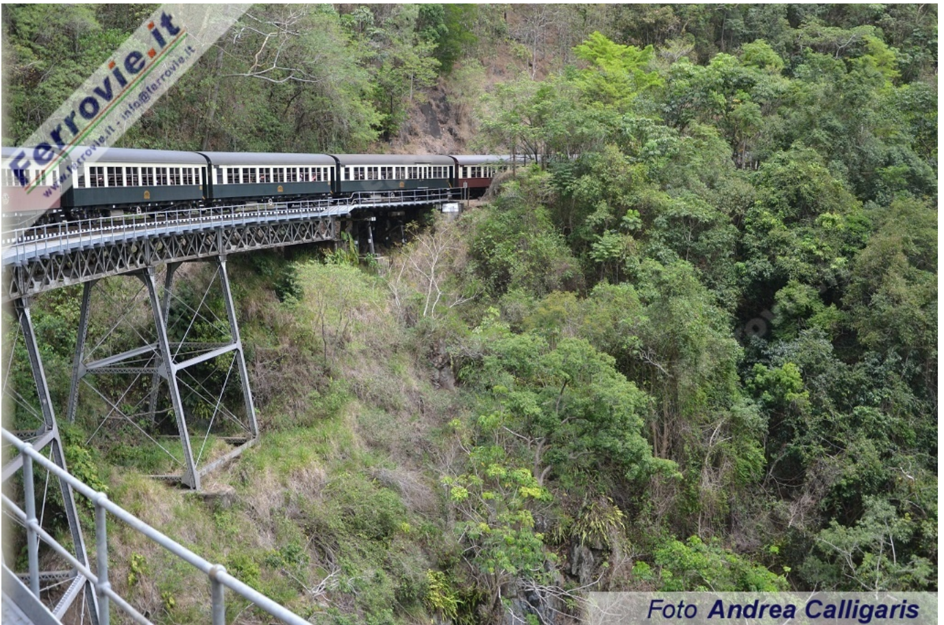
69 Attraversamento del ponte di Stoney Creek. (Foto Andrea Calligaris, 10 novembre 2018)
